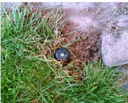
Einbau und Höhenjustierung der Regner und / oder Sprühdüsen
