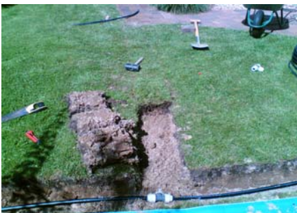
Ausschachten Regnerstichleitungen gemäß Grabenplan und Leitungsplan
