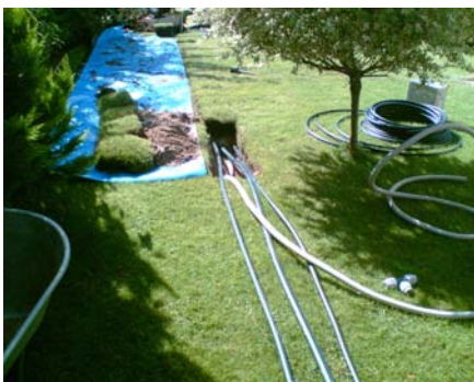
Teilweises Schließen des Grabens
