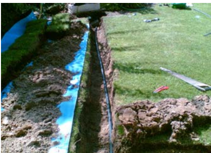
Ausschachten der Leitungsführung gemäß Grabenplan
